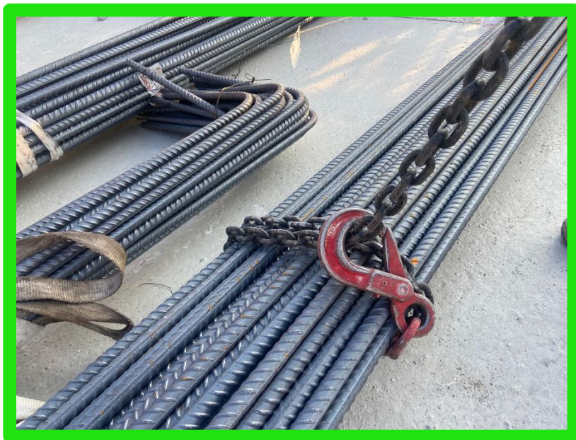
IMBRACATURA CON CATENE IN FERRO (DOPPIO STROZZO)
