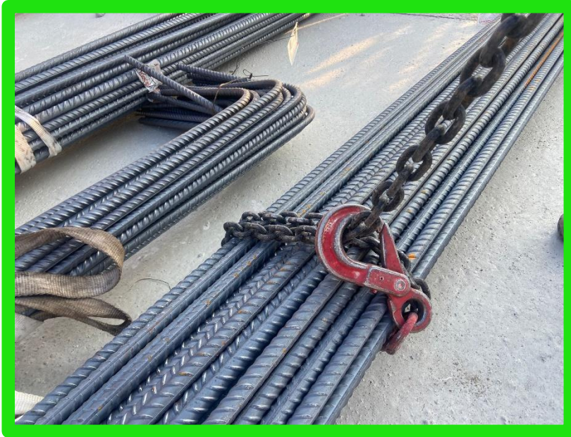
IMBRACATURA CON CATENE IN FERRO (DOPPIO STROZZO)
