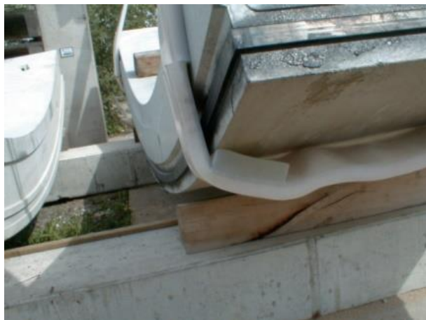
Protezioni in polietilene anti taglio o anti abrasione
