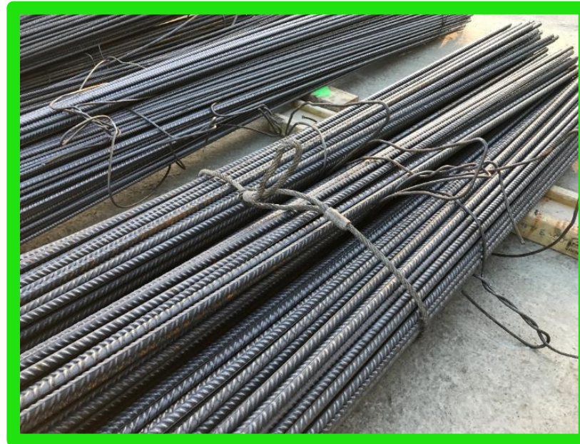
IMBRACATURA CON APPOSITE FUNI DI SOLLEVAMENTO CON ASOLE
