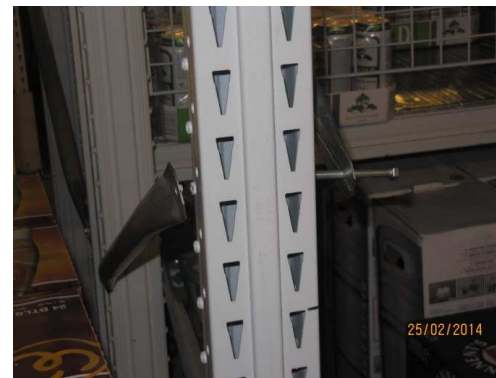
Montante anteriore danneggiato
