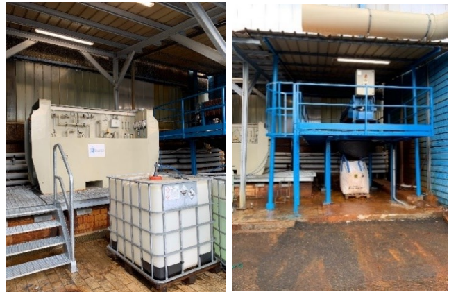
Foto 3 e 4: Dosatore automatico sostanze chimiche
