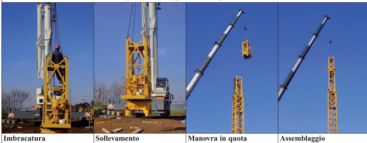
Sequenza montaggio elemento gru a torre
