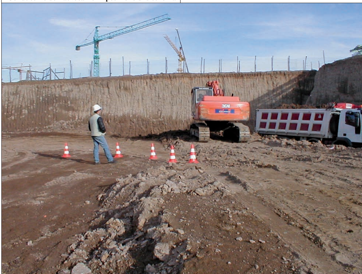
Conducente dell'autocarro in posizione di sicurezza
