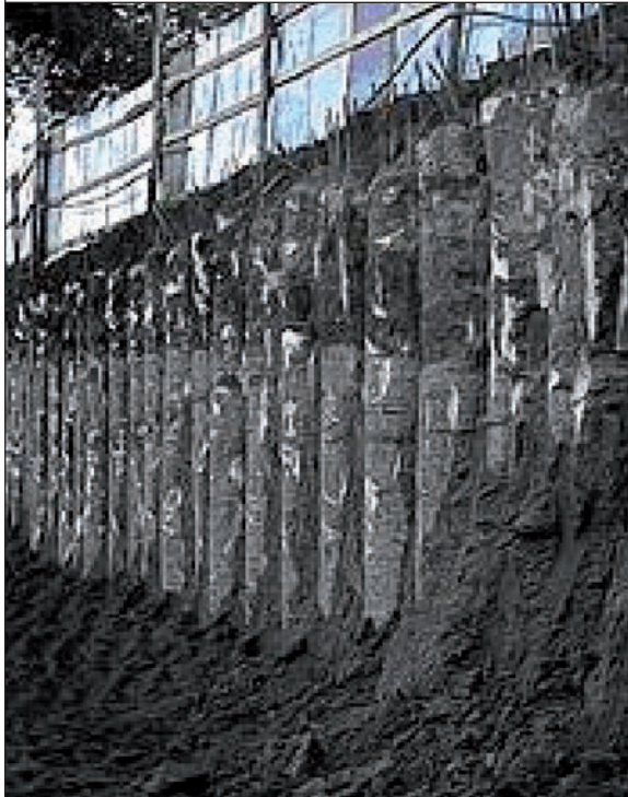
Profilo di scavo contenuto con palificazione
