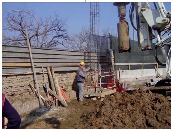
Inserimento armatura
