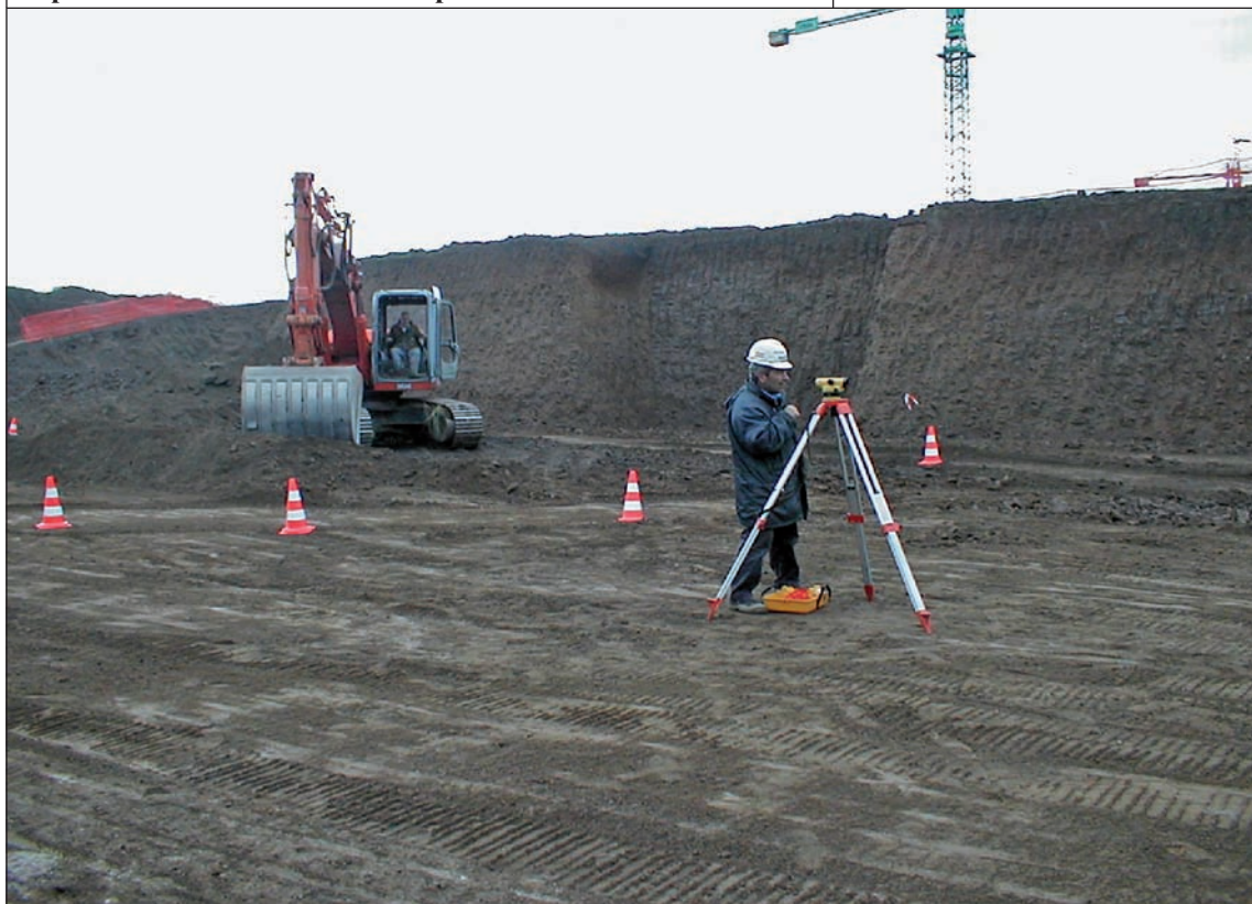
Separazione di attività durante operazioni di movimento terra
