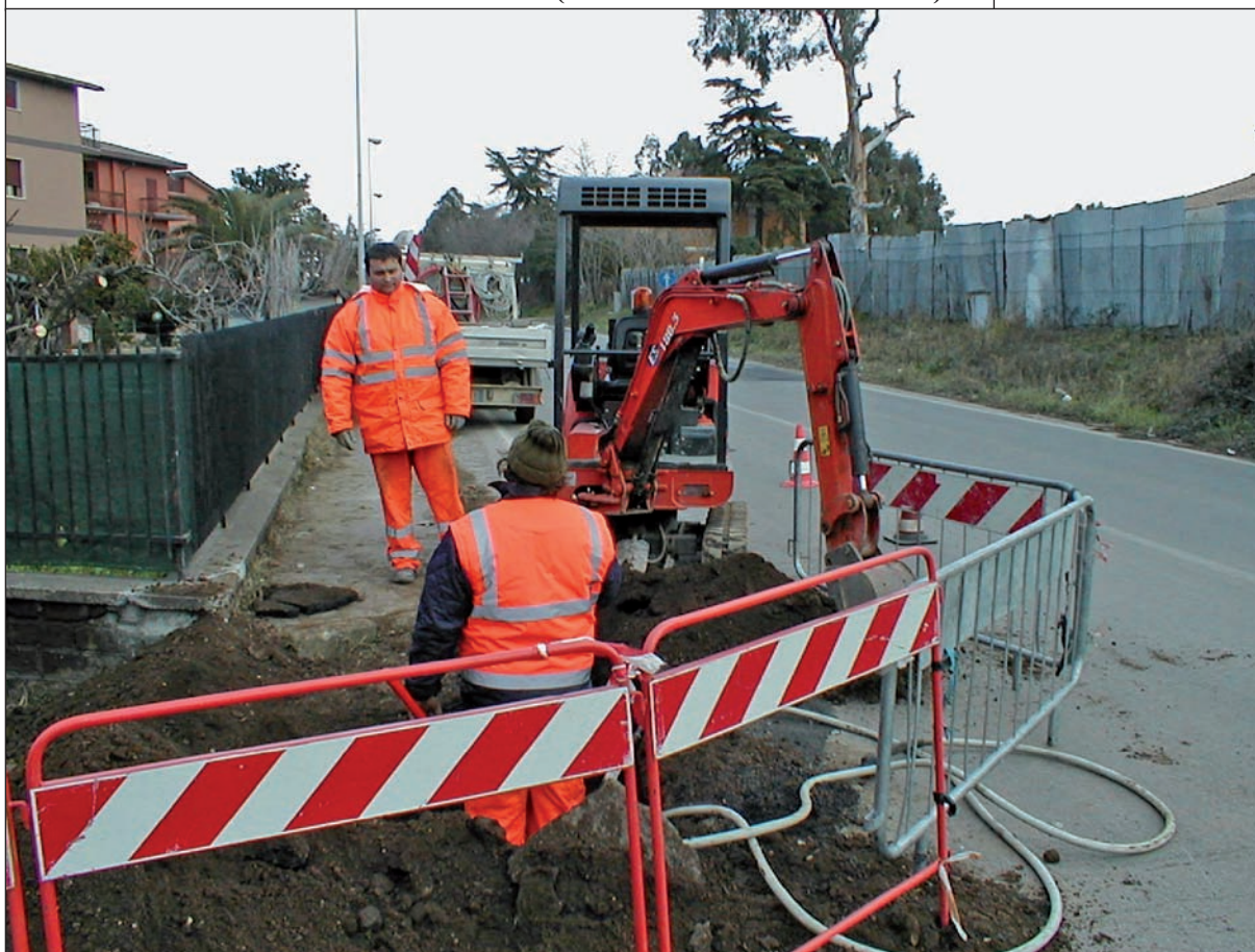
Lavoratore a terra in condizioni di sicurezza (manovratore fuori della cabina)
