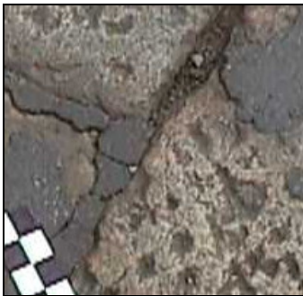
Figura 13: Asportazione di sigillante dai giunti
