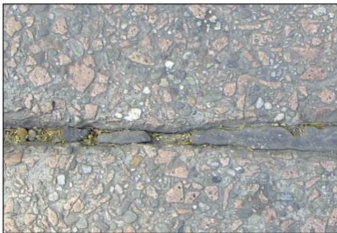
Figura 5: Degrado dei giunti precedentemente sigillati
