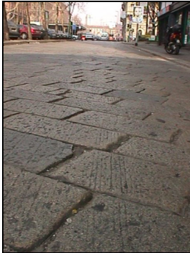
Figura 12: Eccessiva apertura dei giunti non sigillati
