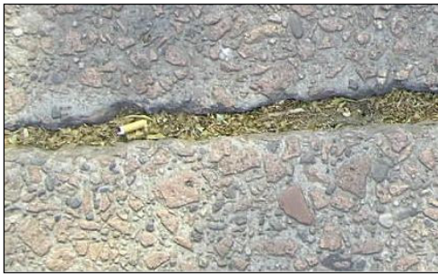
Figura 4: Degrado dei giunti non sigillati
