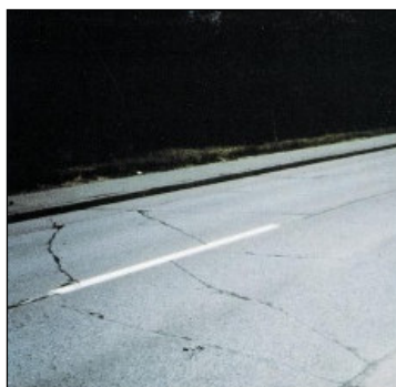
Figura 3: Esempio di fessurazione trasversale
