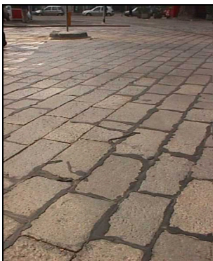
Figura 14: Spandimento di legante sul massello
