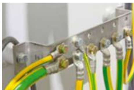
Foto 4: collegamenti a terra per l'equipotenzialità delle masse
