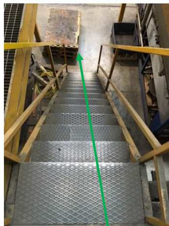
Foto 2: scala ripida e 3 bancali sovrapposti che ingombrano il passaggio
