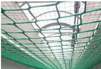
Foto 3: esempio rete anticaduta di protezione sotto i lucernari
