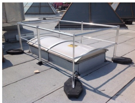
Foto 6: protezioni collettive permanenti: parapetti con zavorre
