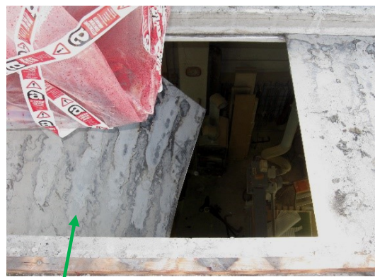
Foto 2: lastra di ondulato plastico sfondata
