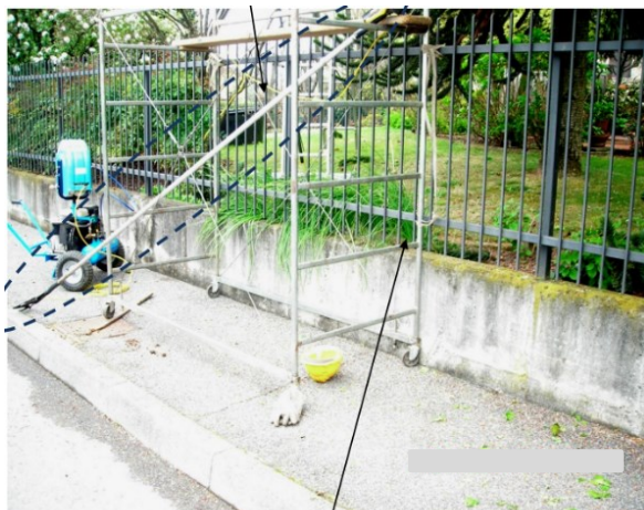
Trabattello montato in modo incompleto
