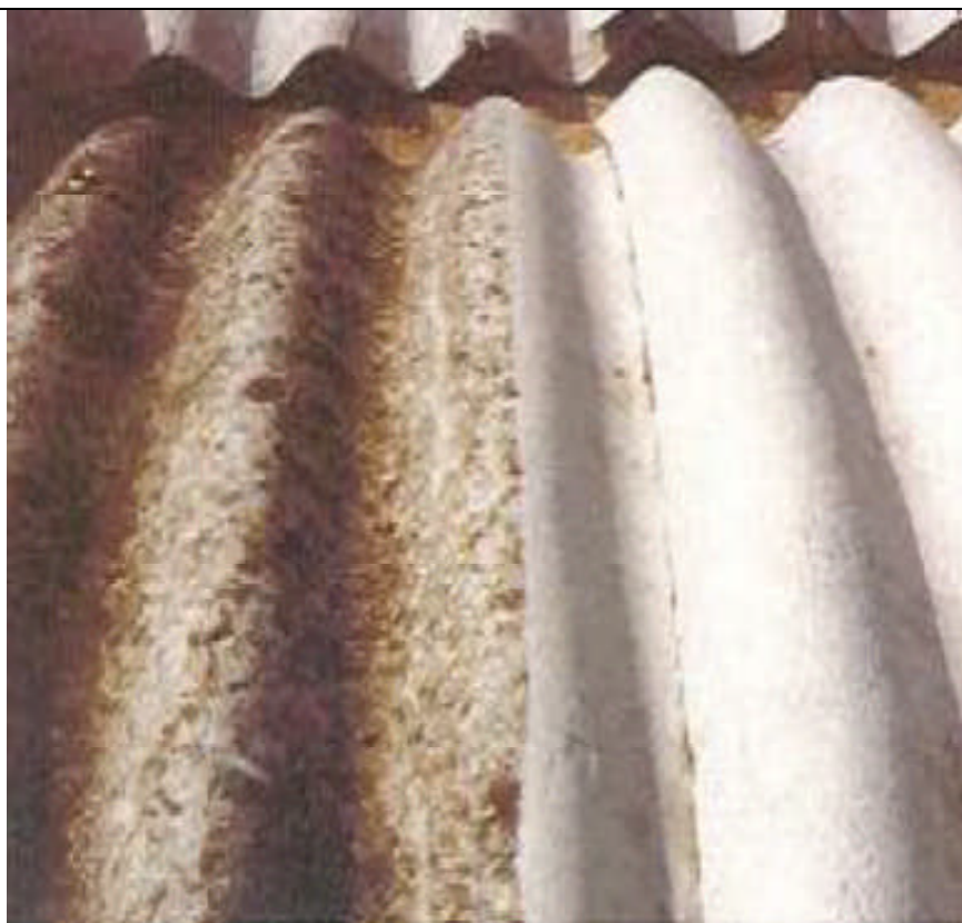
Fig. 02 - Particolare di una lastra in AC prima e dopo l'intervento di pulizia con idropulitrice
