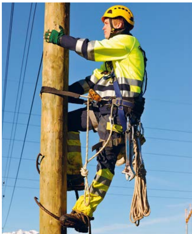
Figura 6 Montatore di linee aeree mentre sale su un palo di legno con ramponi e cintura di posizionamento. In questo caso non è necessario un ulteriore sistema di arresto caduta.
