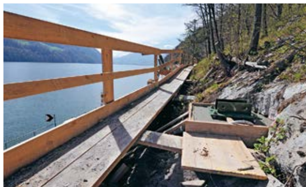
Figura 30 In caso di lavori importanti, ad es. ancoraggio e messa in sicurezza di pareti rocciose, gli accessi ai posti di lavoro devono essere messi in sicurezza. La protezione laterale deve essere adattata alle condizioni del luogo (secondo l'OLCostr, artt. 15 e 16).
