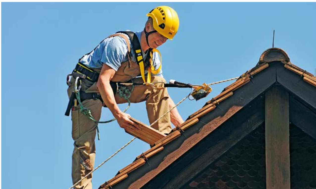
Figura 9 Lavori di riparazione eseguiti da un operaio munito di imbracatura anticaduta e fune di sicurezza.
