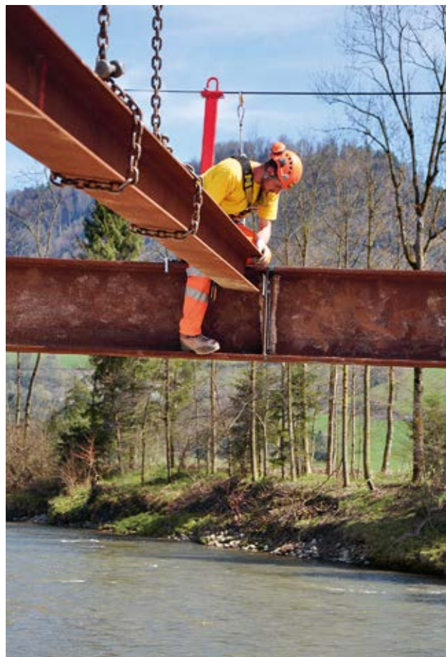
Figura 25 Montaggio di una struttura in acciaio con dispositivo di sicurezza su linea vita orizzontale.
