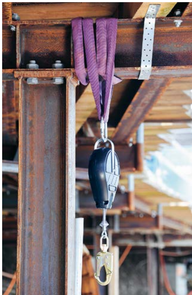
Figura 23 Fissaggio della fune di sicurezza all'elemento portante di una struttura.
