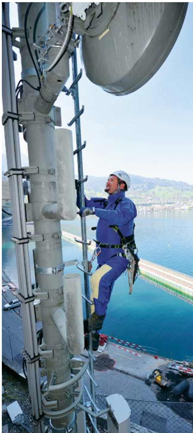
Figura 14 Montatore assicurato con un dispositivo di risalita sul binario di guida di una scala fissa a pioli.
