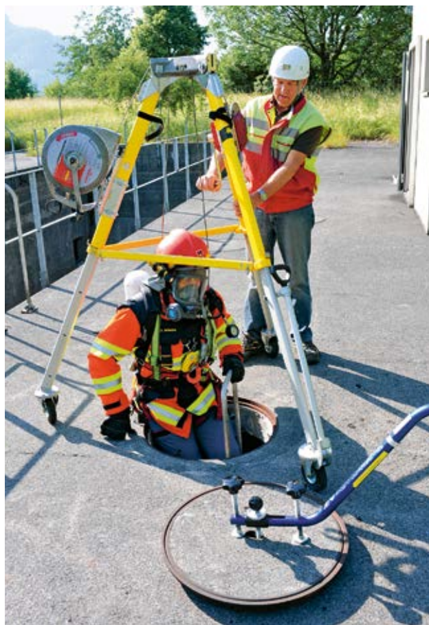
Figura 20 Discesa in un pozzo tramite una scaletta. L'operaio è assicurato con un'imbracatura e un dispositivo anticaduta provvisto di manovella di salvataggio che permette di sollevarlo dall'esterno in qualsiasi momento.
