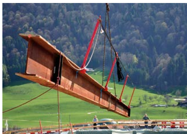
Figura 26 Pianificazione accurata: una trave in acciaio viene sollevata con un sistema di linee vita premontato.
