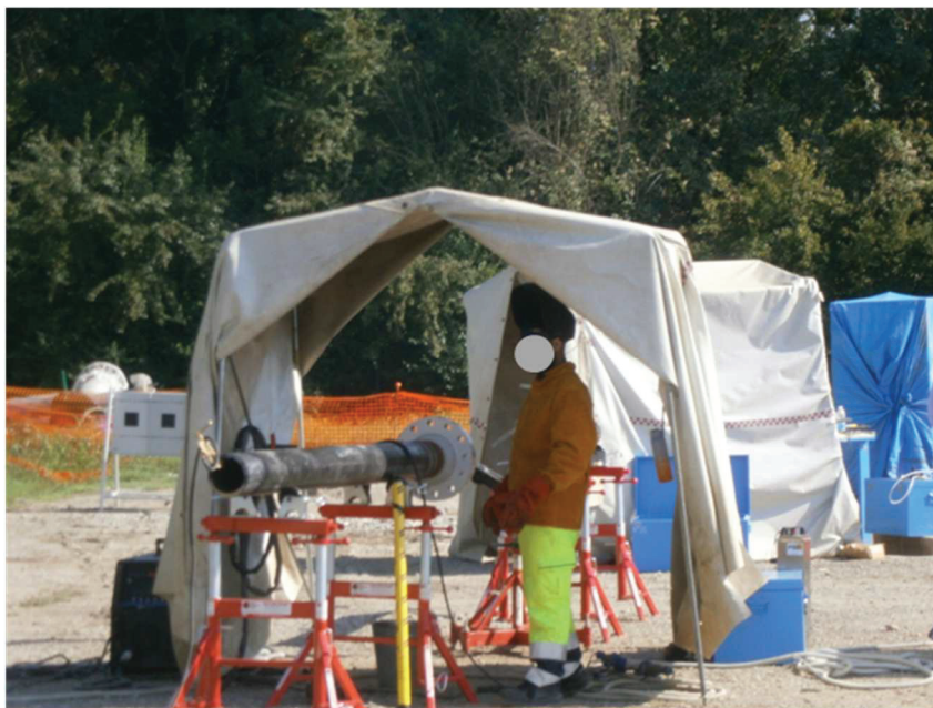
Foto 5: lavorazioni di saldatura all'aperto eseguite all'ombra
