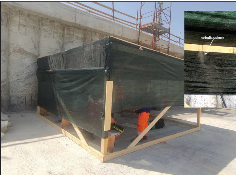
Foto 2: miglioramento della stessa struttura di foto 1 con telo-rete laterale per ampliare la zona d'ombra, inserimento sedute e utilizzo di nebulizzatore.
