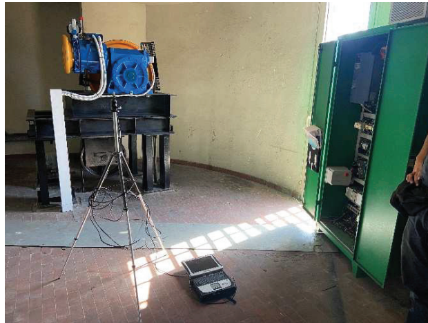
Foto 4 – Locale argano, ascensore 1 posto ultimo piano edificio
