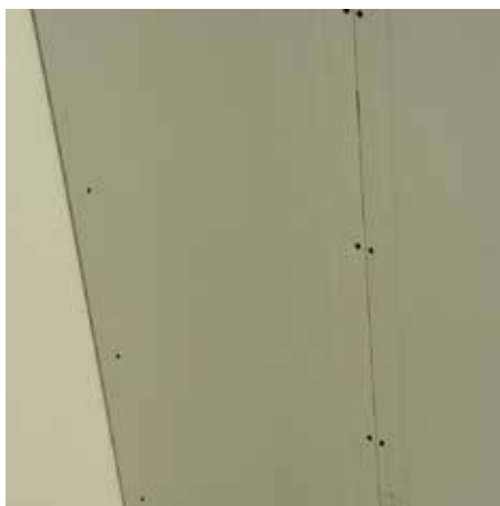
Avvitatura delle lastre solo sui montanti
