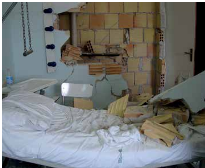
Danneggiamento e crollo di elementi non strutturali a seguito di un terremoto
