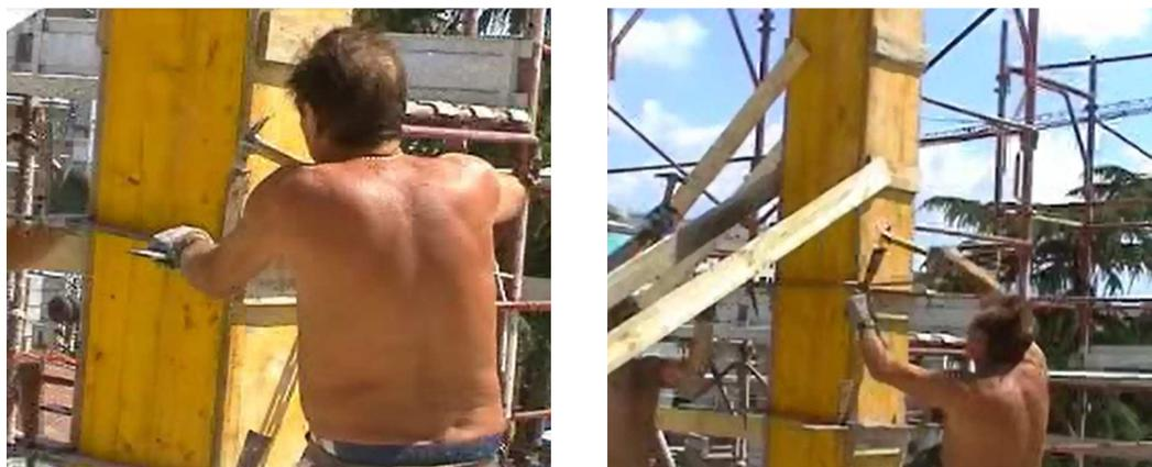
L'incravattatura comporta il fissaggio delle cosiddette cravatte per tenere unite le tavole durante la fase di getto e successiva maturazione del cemento.
