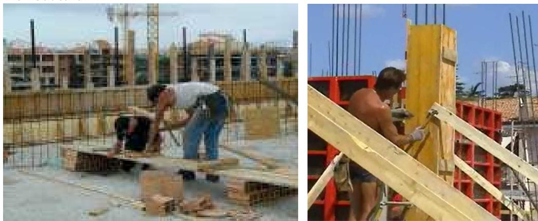
L'inchiodatura delle tavole di legno viene effettuata manualmente con un martello, successivamente alla posa in opera delle armature, al fine di costruire i casseri entro i quali avverrà la colata di calcestruzzo.
