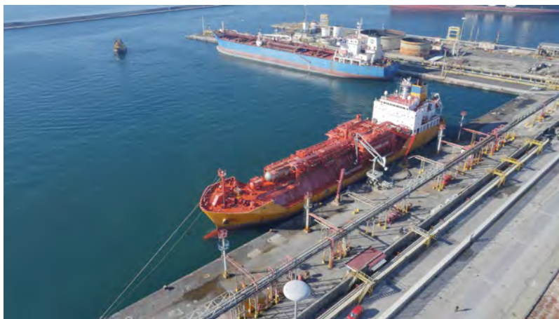
Figura 2. Napoli: Fase di scarico da nave cisterna GPL al pontile PO 68 della DP. [12]
