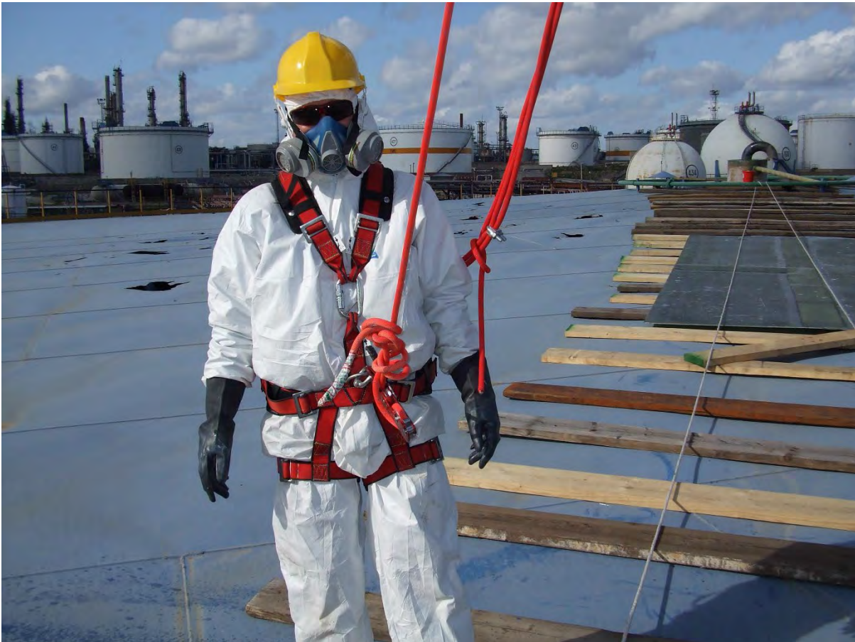
Figura 5. L'operatore, dotato di tutti i DPI necessari, è costantemente agganciato al sistema di recupero.
