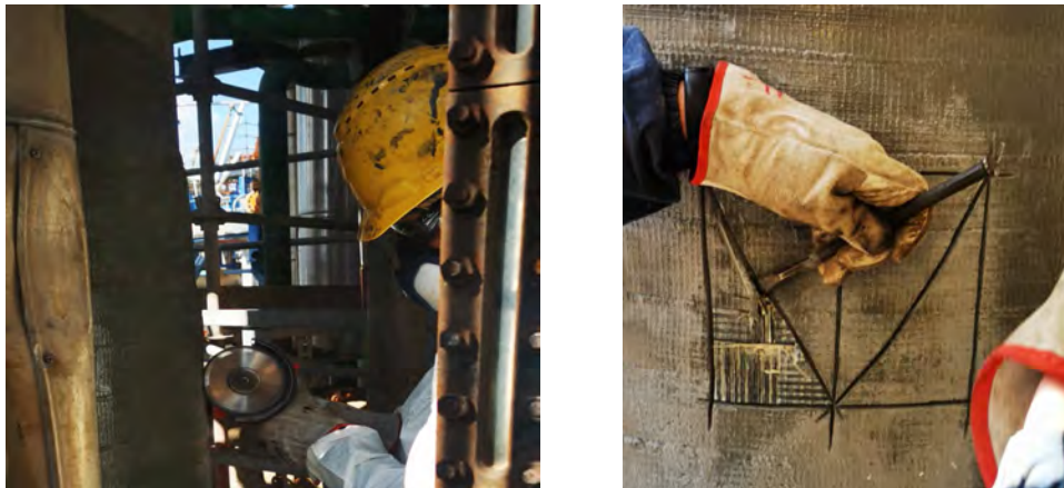
Figura 8. Rimozione del rinforzo strutturale (Archivio V.E.D. s.r.l.)
