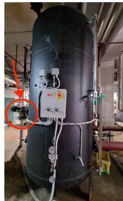
Figura 2. Vaso moderno Prepressurizzato a PC e LV.
