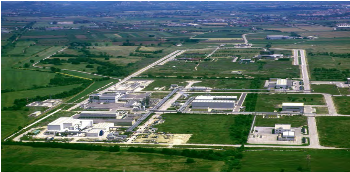
Figura 1. Vista aerea del CIRA
