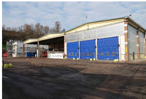
Figura 1. Vista generale impianto
