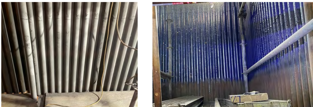
Figura 2. Preparazione e trattamento HVTS in parete membranata
