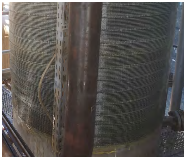
Figura 7. Mantello della colonna riparata (DN 1000) (Archivio V.E.D. s.r.l.)
