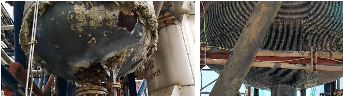
Figura 5. Esempio di rinforzo su una colonna (Archivio V.E.D. s.r.l.)
