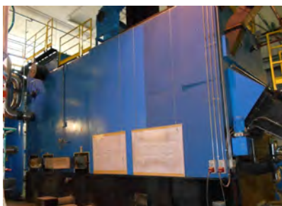
Figura 1. Caldaia a cippato di legna
