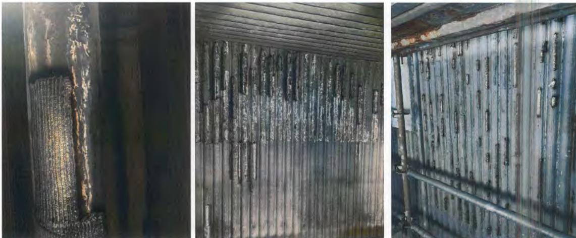
Figure 2. Ripristino di inconel sui tubi screen 1° passaggio.
