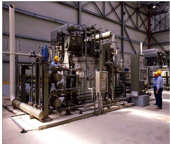
Figura 2. Centrale Aria Compressa.
