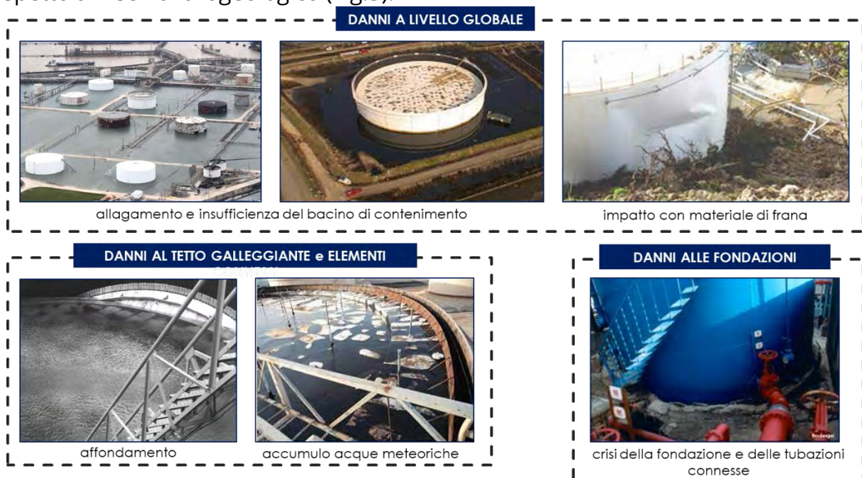
Figura 3. Vulnerabilità dei serbatoi atmosferici rispetto al rischio idrogeologico
