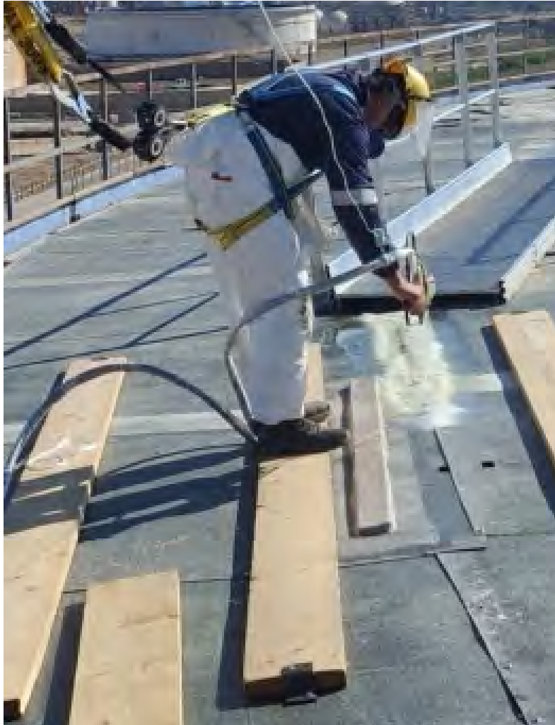
Figura 6. L'operatore durante la fase di saldatura dei laminati in materiale composito. Esso opera sul piano di camminamento e agganciato costantemente al sistema di recupero.
