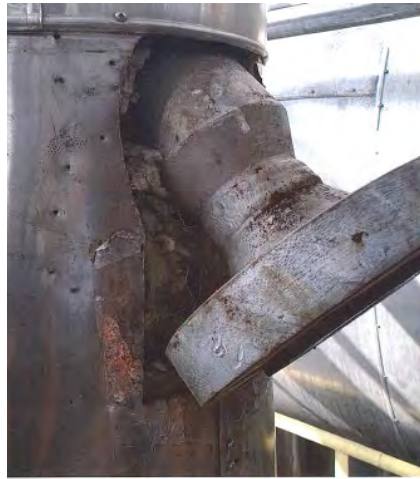
Figura 7. Punto di ingresso per l'endoscopia interna della tubazione
