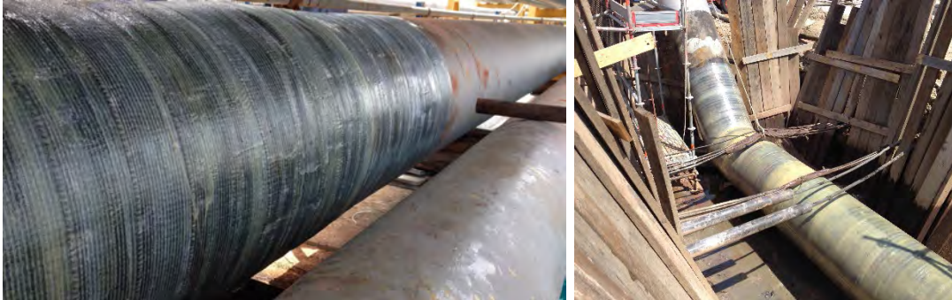
Figura 4. Rinforzi strutturali (Archivio V.E.D. s.r.l.)
