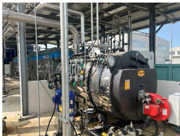
Figura 11. Generatore di vapore
