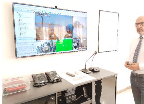
Figura 9. Centro di coordinamento emergenza della raffineria di Milazzo
