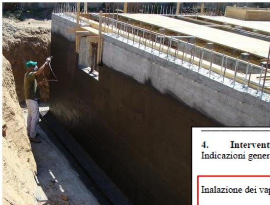
Impermeabilizzazione mura di fondazione - L'impermeabilizzante bituminoso è stato applicato mediante airless direttamente sul supporto in calcestruzzo delle mura di fondazione
