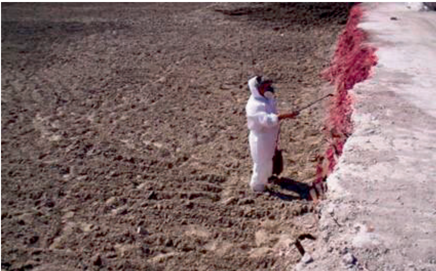
Figura 21: Incapsulamento di fronti di scavo con Mca; vedi Riferimenti alle immagini
