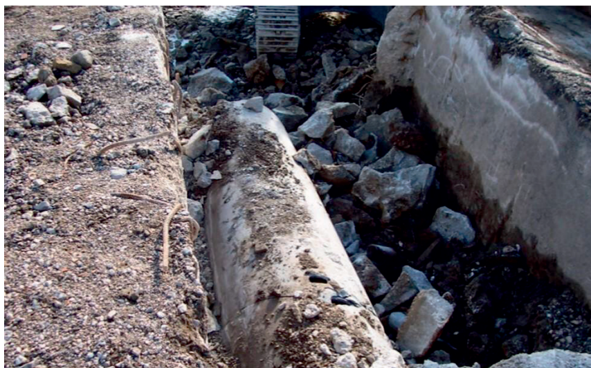
Figura 50: Tubazione in cemento-amianto; vedi Riferimenti alle immagini
