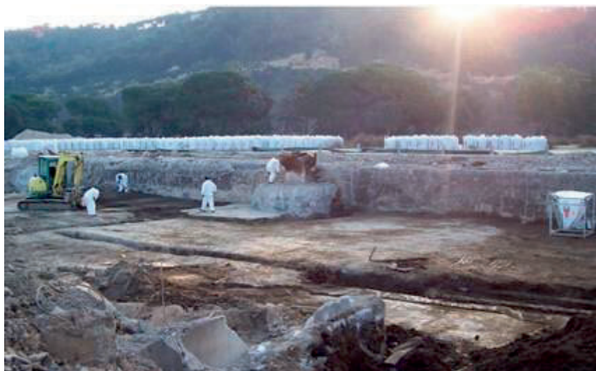
Figura 53: Cantiere di bonifica suolo contaminato da Mca; vedi Riferimenti alle immagini
