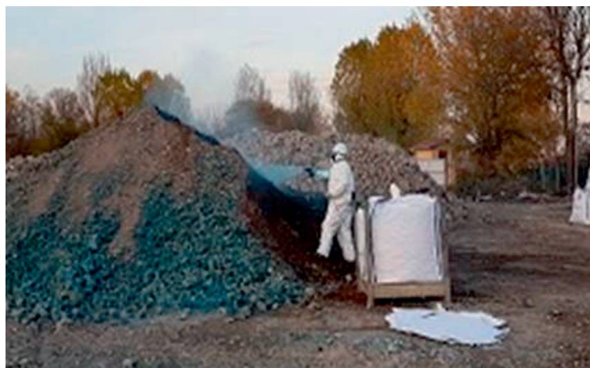
Figura 59: Incapsulamento dei cumuli di suoli contaminati preliminarmente all'insaccamento in big-bags; vedi Riferimenti alle immagini
