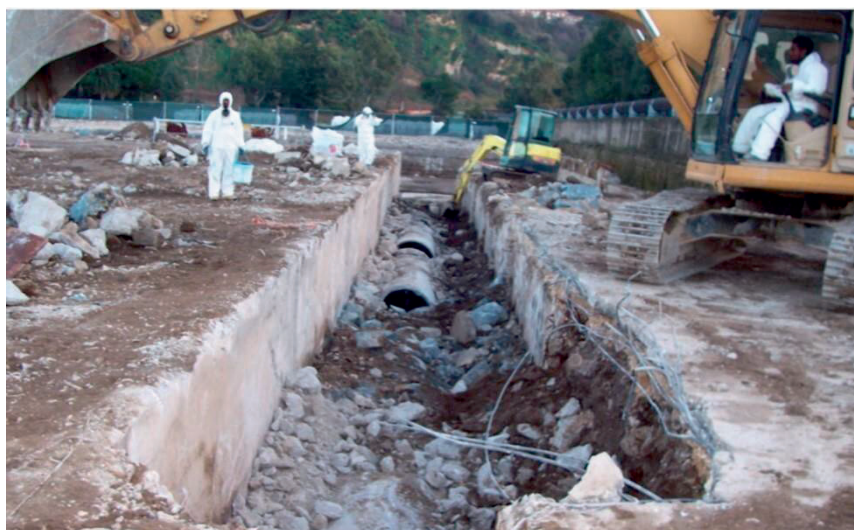
Figura 51: Tubazione in cemento-amianto; vedi Riferimenti alle immagini
