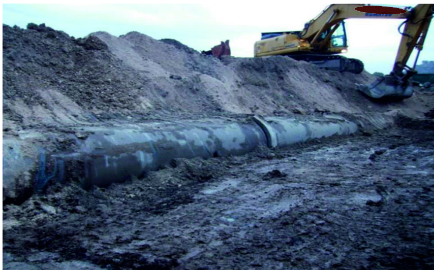
Figura 45: Tubazione in cemento-amianto; vedi Riferimenti alle immagini
