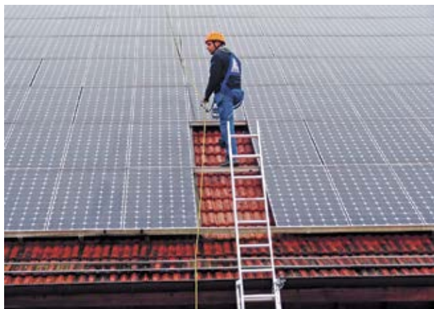
Fig. 18 Fune tirata oltre il tetto e ancorata, con dispositivo anticaduta di tipo guidato
