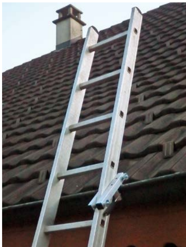
Fig. 19 Accesso sicuro al tetto per lavori di breve durata > scala a pioli bloccata al bordo tetto
