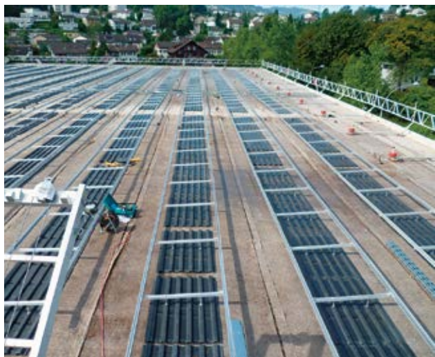
Fig. 2 Montaggio di un impianto solare con protezione laterale temporanea su tutti i bordi
