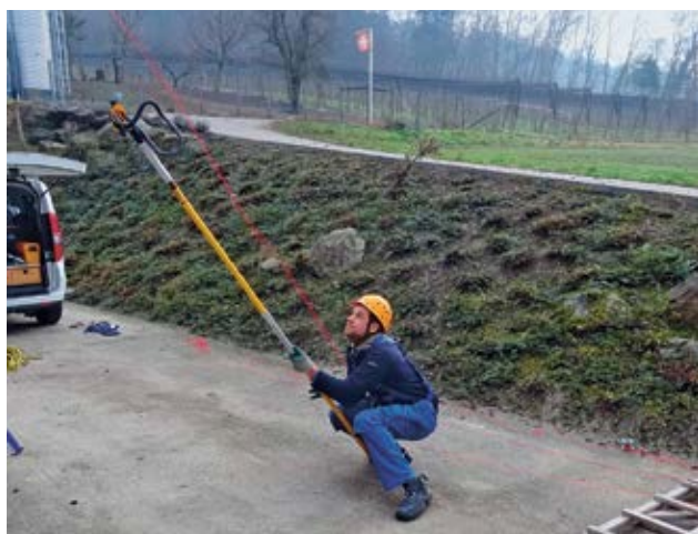
Fig. 17 Sistema di lancio con fionda industriale
