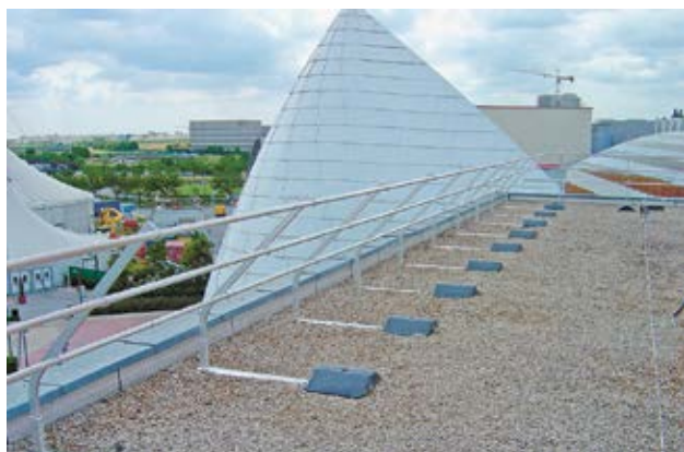
Fig. 6 Protezione laterale senza perforazione del manto di copertura per un utilizzo temporaneo o permanente
