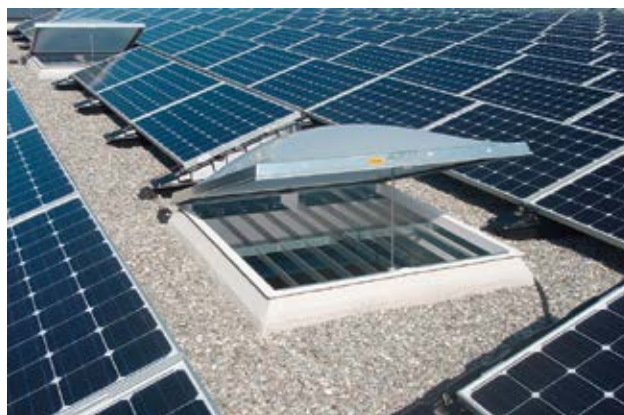
Fig. 1 Lucernario con griglia di sicurezza contro lo sfondamento
