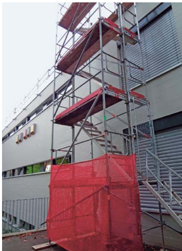
Fig. 3 Accesso sicuro tramite un corpo scala (ponteggio)
