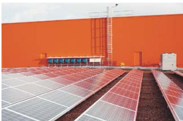
Fig. 11 Scala a pioli fissa con gabbia di protezione dorsale
