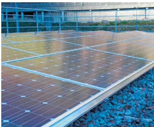
Fig. 4 Impianto solare su tetto piano con parapetto perimetrale fisso
