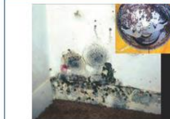
Figura 1 Parete e griglia immissione aria contaminati da muffe
