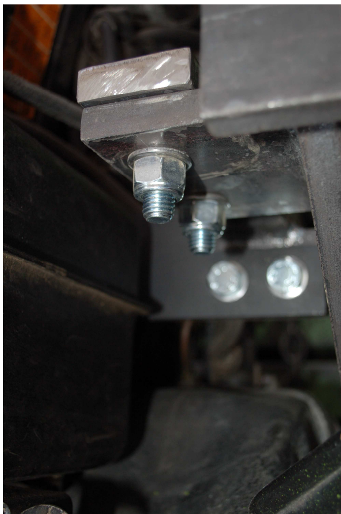
Figura 8. Collegamento dell'elemento A2 alla traversa.
